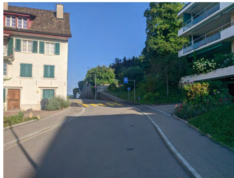
Strehlgasse > Sichtweiten bei T50 > Schulweg
