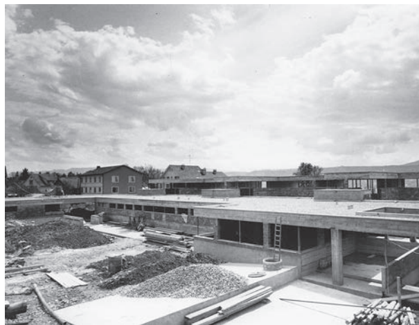
Die Bauarbeiten am neuen Primarschulhaus schreiten voran!
