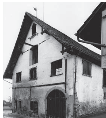
Vogteieingang vor dem Umbau
