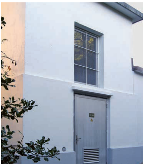
Links: Die kürzlich sanierte Transformersstation Dorf
