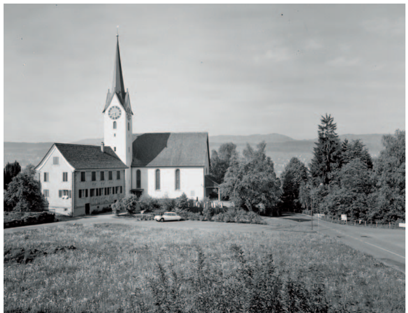
Das alte Schulhaus stand genau über der heutigen Tunnelausfahrt und vor der Kirche war ein Friedhof.
