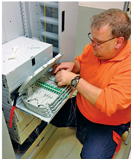
Michael Thome, Arnold AG, führt im Auftrag von meifi.net Spleissarbeiten in der Zentrale aus.
