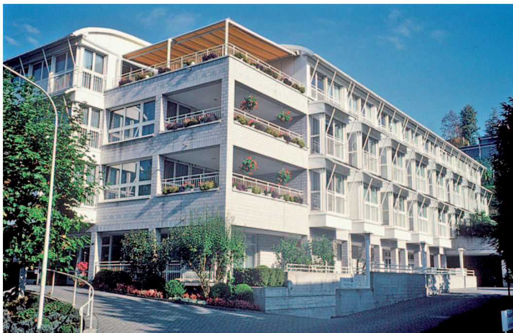
Alters- und Pflegeheim (APH) Herrliberg an der Schulhausstrasse
