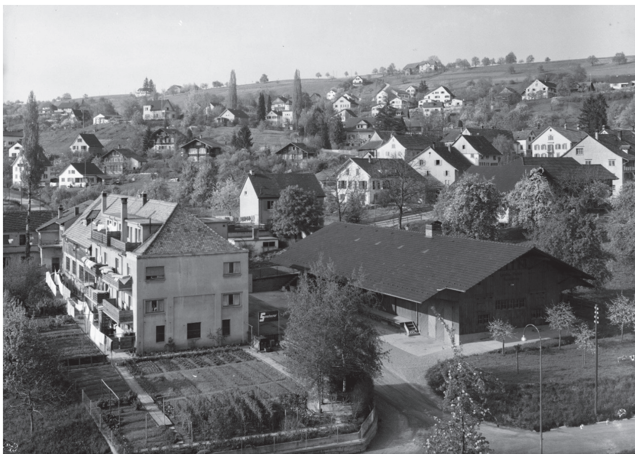
Fotograf Fritz Bopp ist 1956 vermutlich auf das Baugerüst des katholischen Kirchturms geklettert und hat die Geschichte der Landi auf seine Weise festgehalten.
