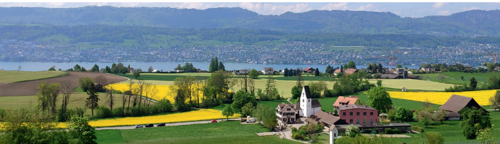
Blick auf die Kirche Wetzwil und das neue Schulhaus (Aufnahme vom 1. Mai 2022)
