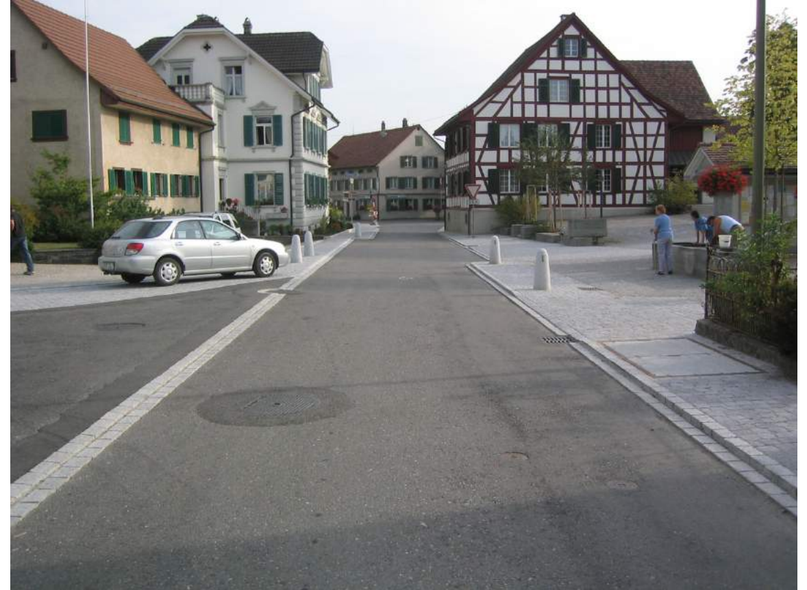
Seitlicher Belagswechsel (Beispiel Pflasterung)
