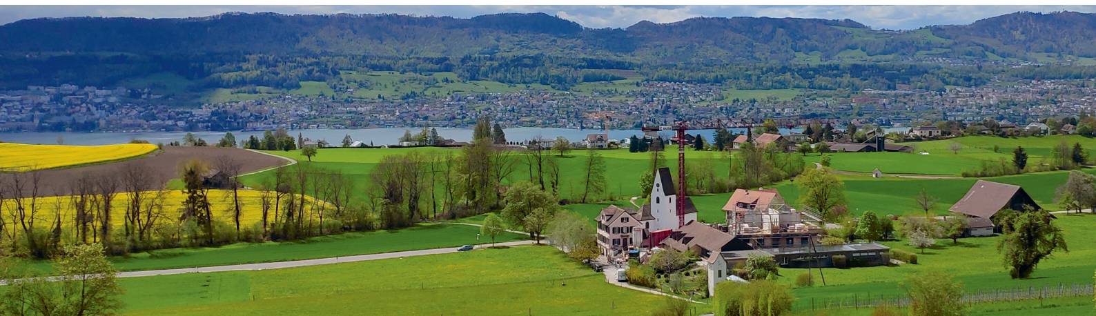
Blick auf die Kirche Wetzwil und die Schulhaus-Baustelle (Aufnahme vom 5. Mai 2021)
