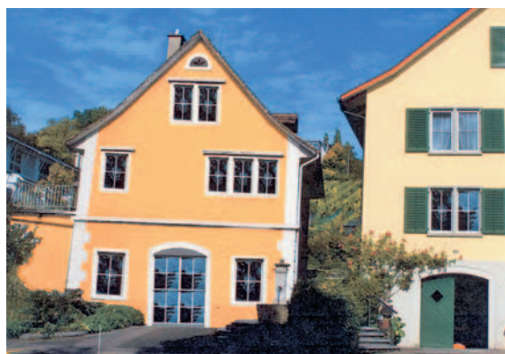
... und wie es nach der Sanierung aussehen könnte.
