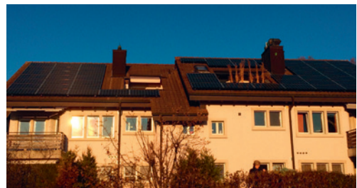
Dach der Ackerstrasse 3, fast 100m 2 sind belegt
