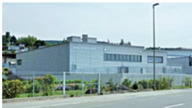
Das neue Biofiltrationsgebäude bildet mit Werkhof eine architektonische Einheit.
