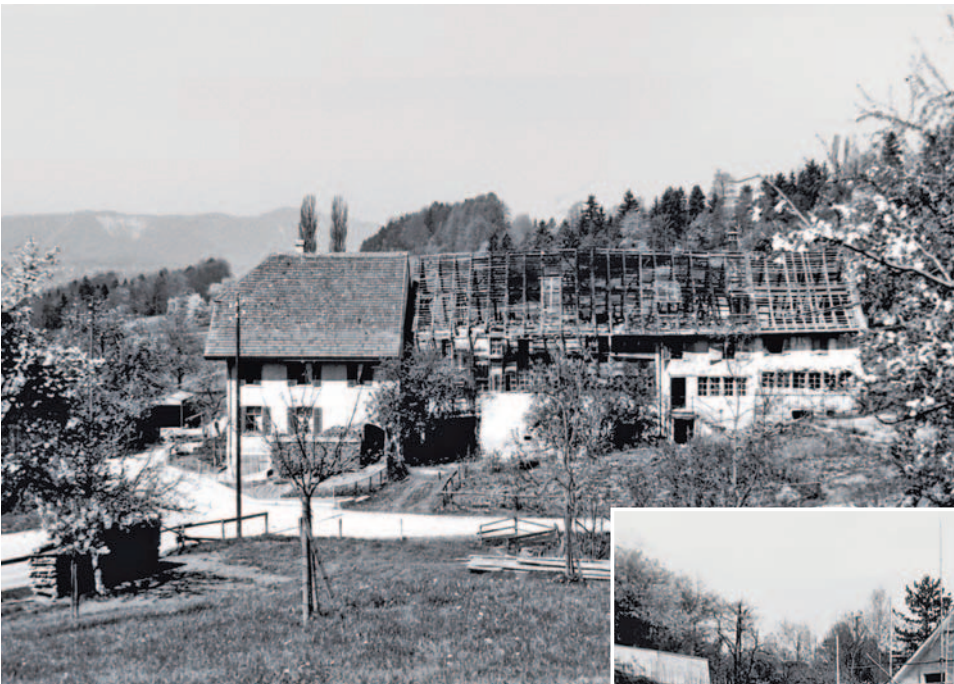
Im Hof wird ein Ständerbau aus dem Jahr 1649 abgerissen.
