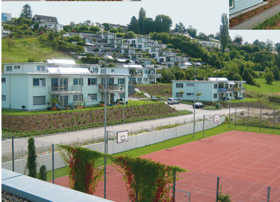
Warmwasser-Kollektoren reflektieren die Sonne
