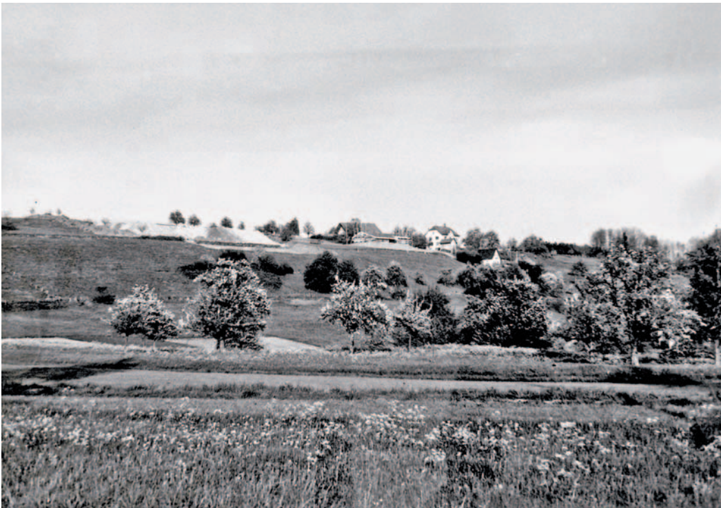
Der Aushub für die Villa Baggenstos (heute Dr. Christoph Blocher) dauerte drei Wochen. Rechts davon steht bereits ein Neubau am Wängirain.
