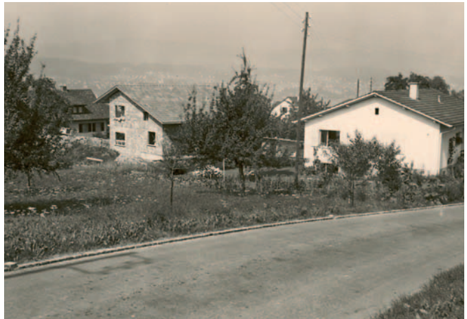
An der Bergstrasse entstehen neue Einfamilienhäuser
