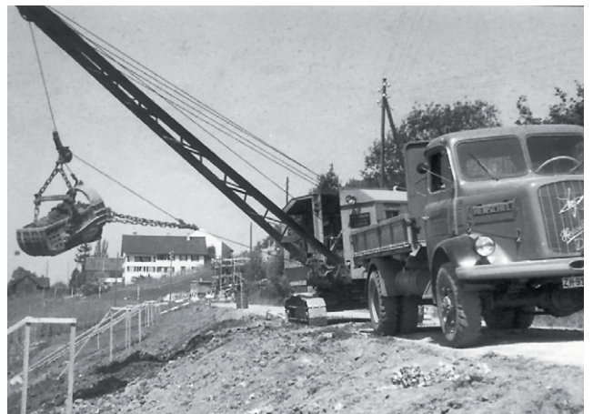
Verbreiterung der Habüelstrasse inkl. Trottoir
