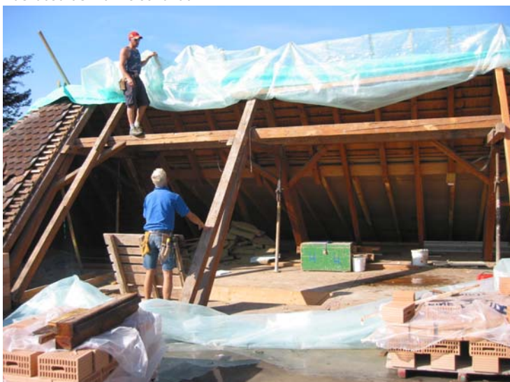
Dachausbruch für Personalraum
