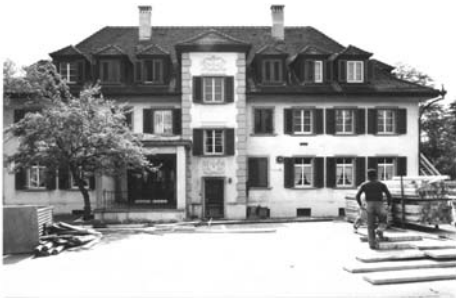
Nordwest-Fassade vor Umbau 1973
