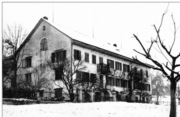
Die Liegenschaft «Felsenau» von Landwirt Alwin Schärer wird abgebrochen!
