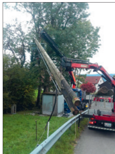
Freileitungsmast wird im Bereich Hof zurückgebaut
